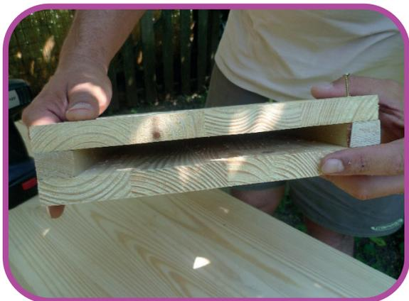
L'espace entre les planches doit être de 1 à 1,9 cm au maximum.
