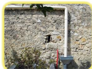
L'eau de pluie des toitures de l'étable est récupérée grâce à un système qui la stocke dans la réserve de 5000 litres sous le sol près du potager.
